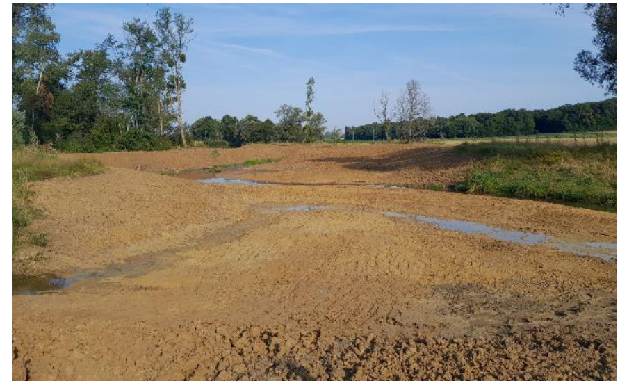
Travaux de reméandrage
