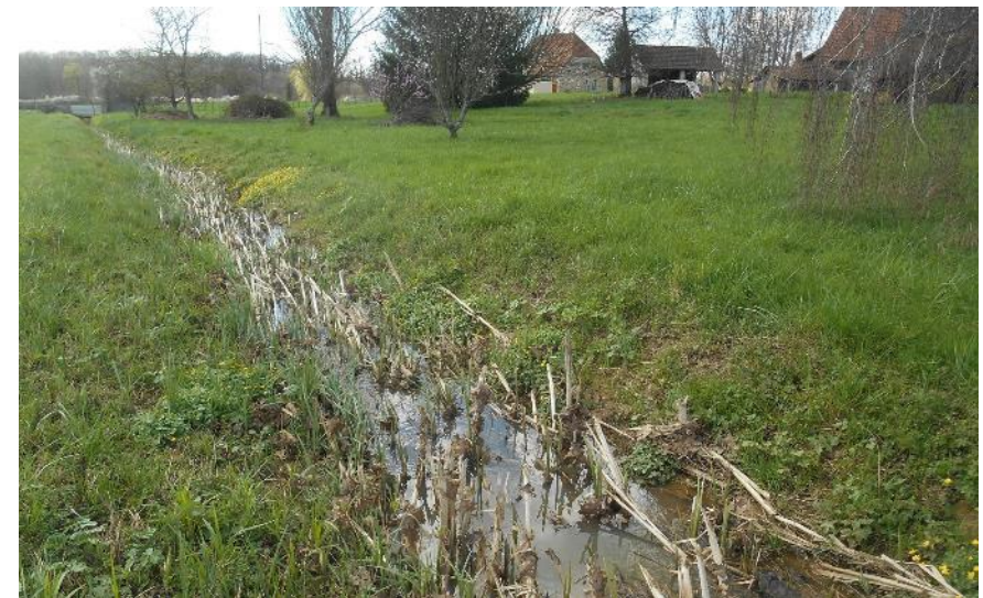
Curage de fossé
